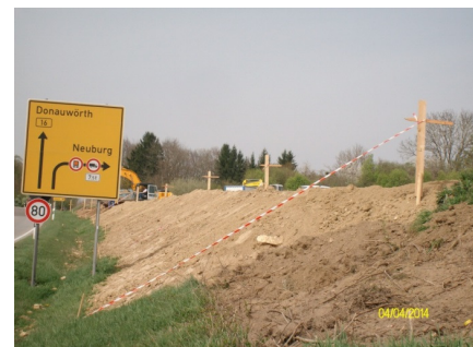
Lärmschutzwall in der Bauphase
