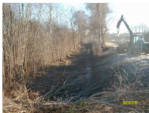
Gehölzpflege entlang eines Grabens
