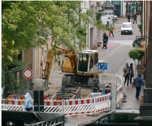
Zugang zu den Geschäften war trotz Baustelle jederzeit möglich
