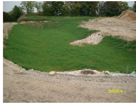
Becken im fertigen Zustand
