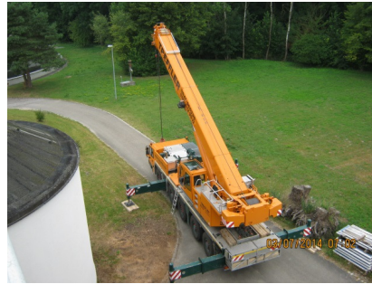
Für die Arbeiten wurde ein Autokran benötigt
