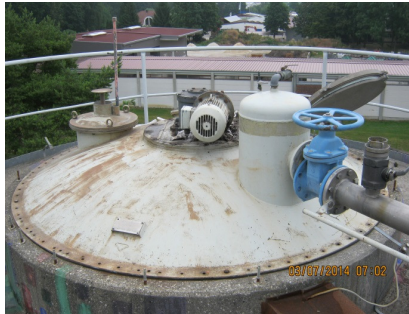
Ansicht des Faulbehälters von oben
