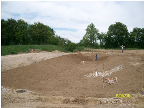
Becken in der Bauphase
