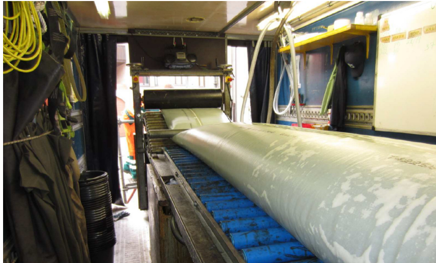
Vorbereitung des Inliners
