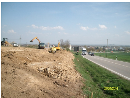
Lärmschutzwall in der Bauphase
