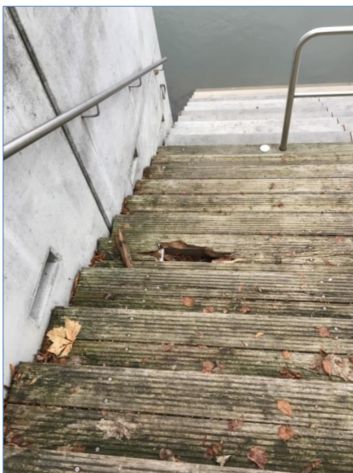
Roßschwemmtreppe mit altem Holzbelag
