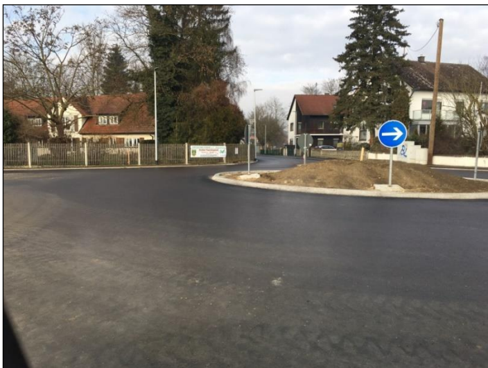
Neuer Kreisverkehr in der Heinrichsheimstraße
