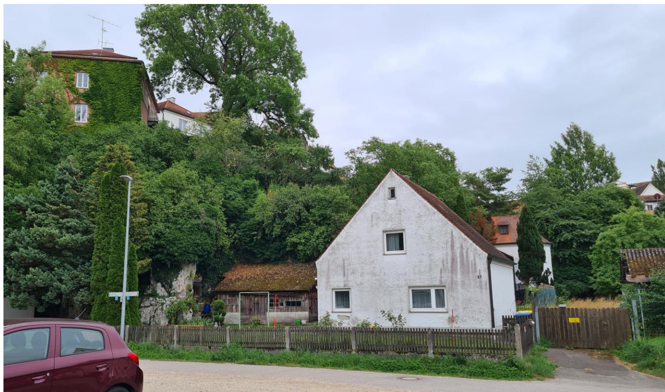
Bestandsgebäude Oberer Brandl B9 (Foto 07/ 2023)
